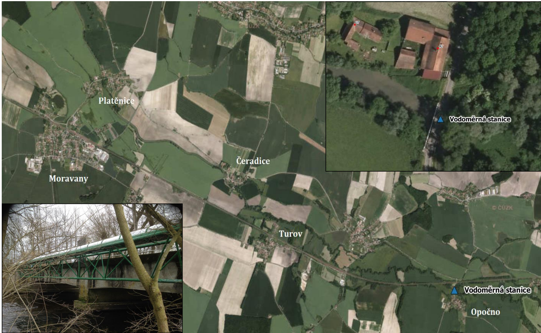
Umístění vodoměrné stanice na mostní konstrukci přes vodní tok Loučná v obci Trusnov
