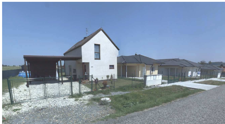
Nevhodné výškové uspořádání ulicového zastavění
