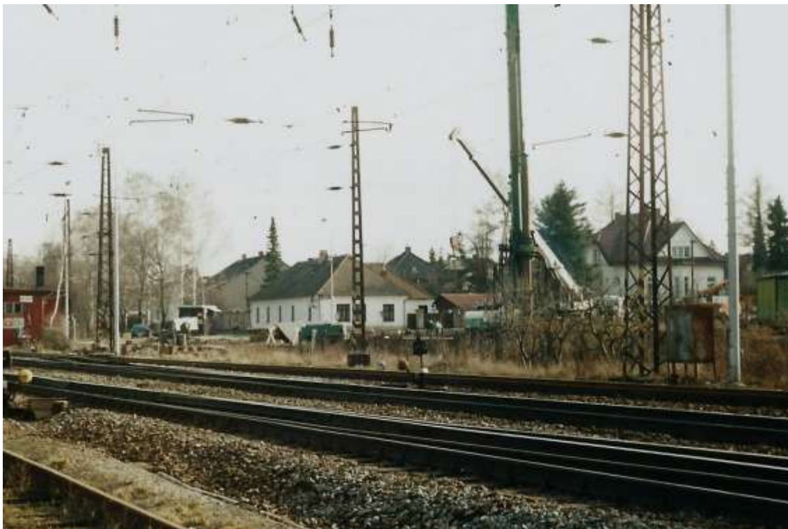
Betonování základů pilířů na jižní straně trati – 12. 1. 2000
